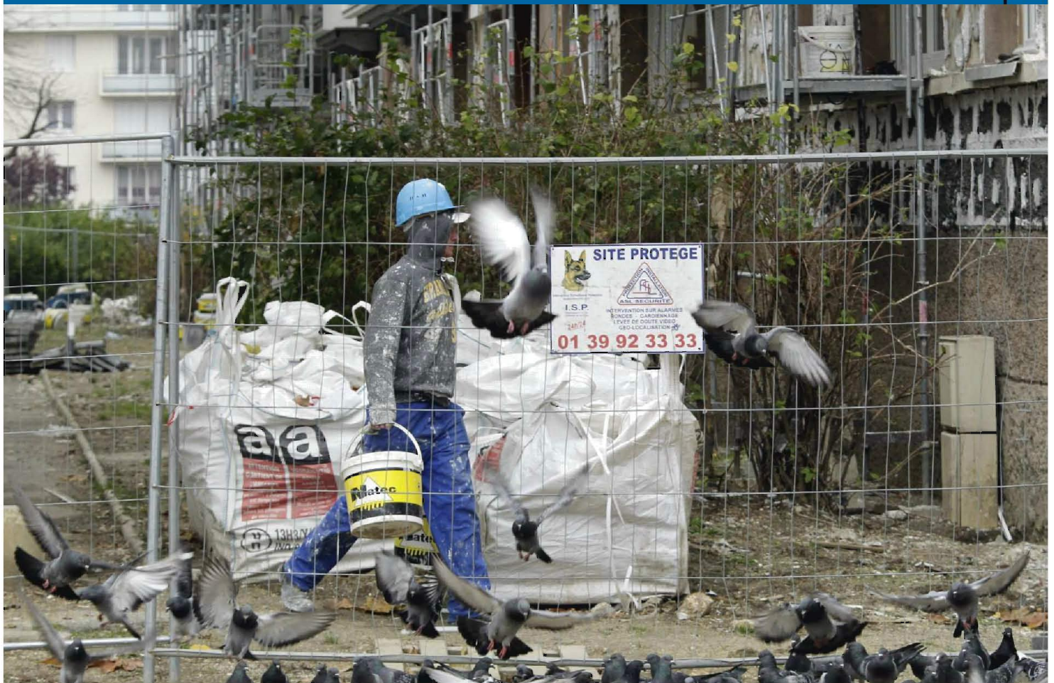
MONTREUIL (SEINE-SAINT-DENIS), HIER. Sur ce chantier de rénovation des HLM du quartier Bel-Air, de nombreux ouvriers sont polonais, salariés d'une société prestataire de services pour une filiale du groupe Bouygues.
